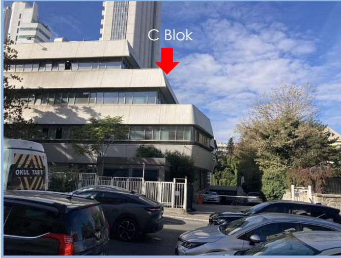
C Blok Görünümü ve Otopark Girişi
