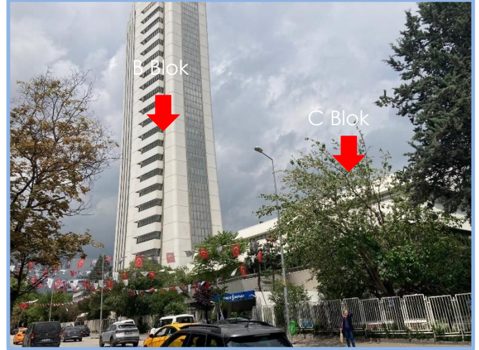
B Blok (Kule) ve C Blok Görünümü
