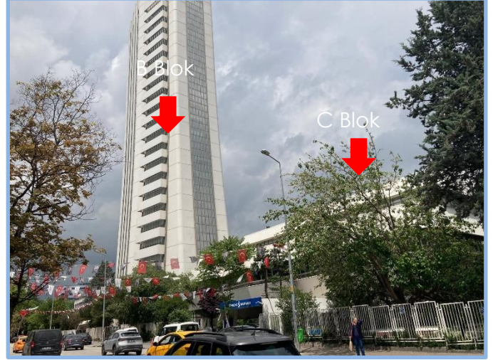
B Blok (Kule) ve C Blok Görünümü
