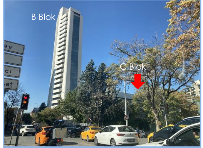
B Blok (Kule) ve C Blok Görünümü
