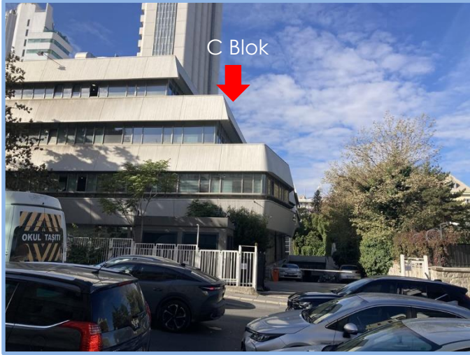
C Blok Görünümü ve Otopark Girişi
