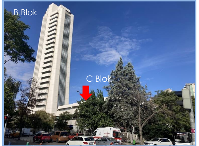
B Blok (Kule) ve C Blok Görünümü
