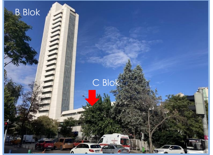
B Blok (Kule) ve C Blok Görünümü
