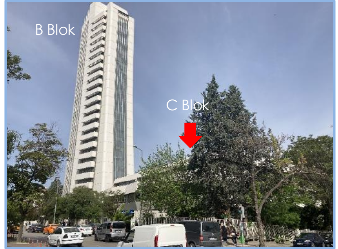
B Blok (Kule) ve C Blok Görünümü
