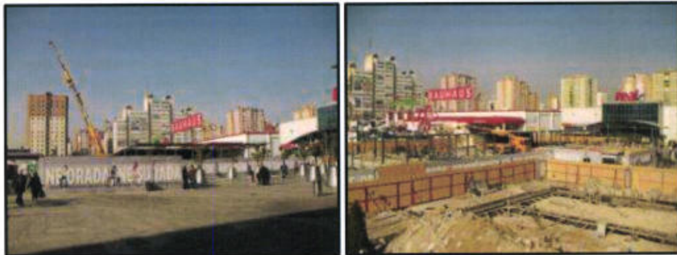
-C Blok İnşaat Sahası-
