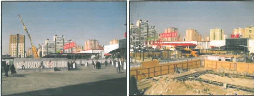
-C Blok İnşaat Sahası-
