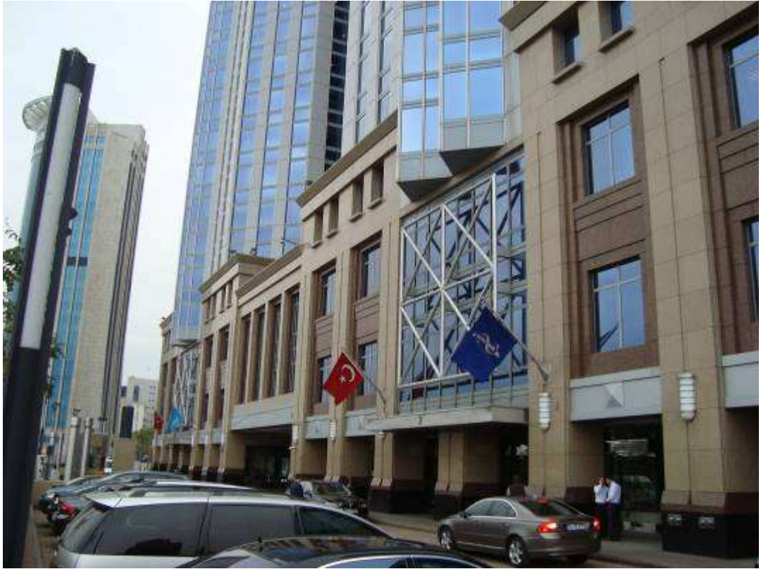
Kule 2 ve 3'ün alt katlarının görünümü
